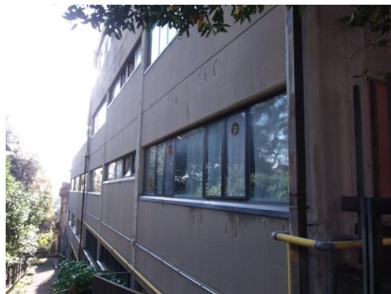
Questa soluzione realizzativa incide sul comportamento termico dell'edificio in quanto le componenti opache non risultano essere particolarmente performanti, poiché sostanzialmente prive di isolamento.
